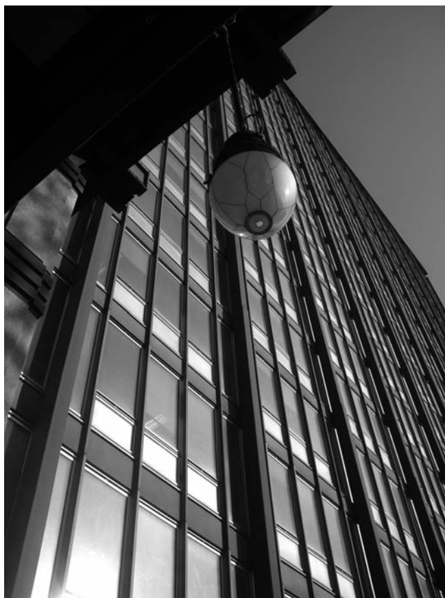
Figura 4. Aldo Morbelli, Domenico Morelli, nuovi uffici Rai, 1962-1968.
